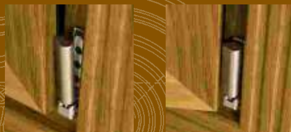
Detalle de bisagra oscilobatiante.
